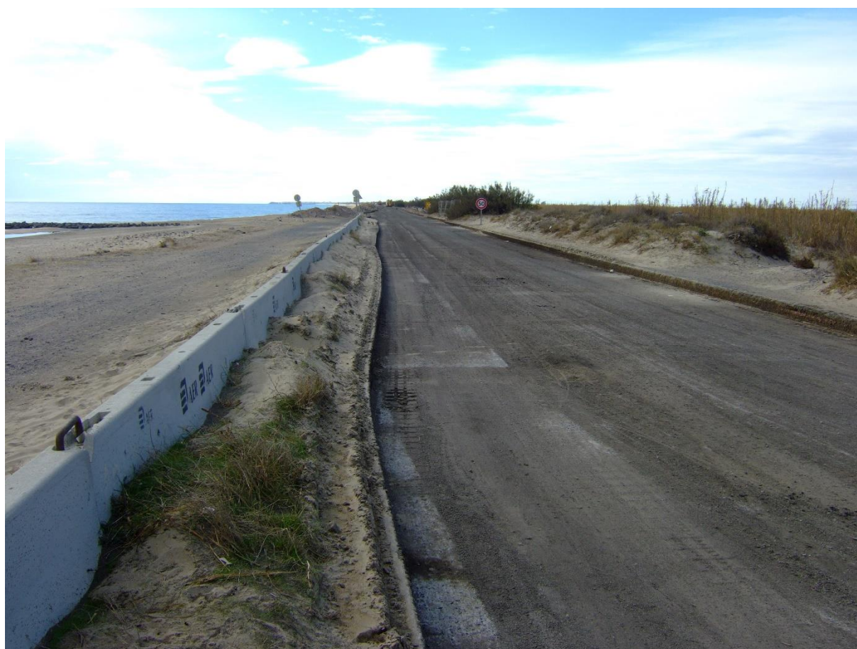
Figure 12 : travaux de suppression de l'ancienne route nationale sur le lido de Sète (photo EID 2010)
