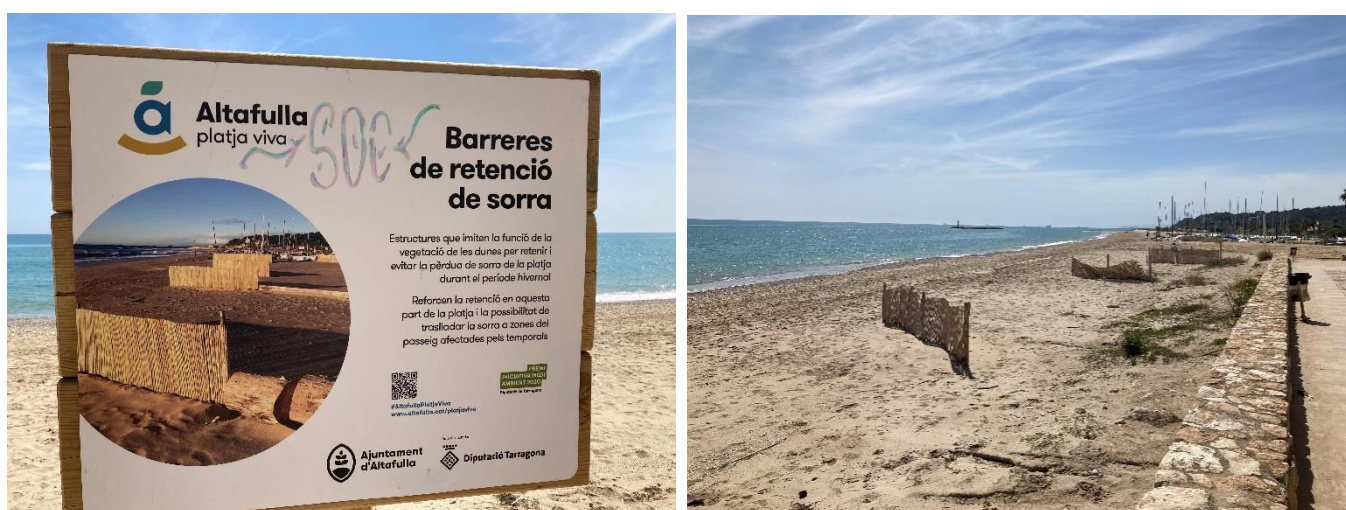
Figure 16 : panneaux d'information (gauche) des travaux effectués (droite) sur la plage d'Altafulla (Espagne)
