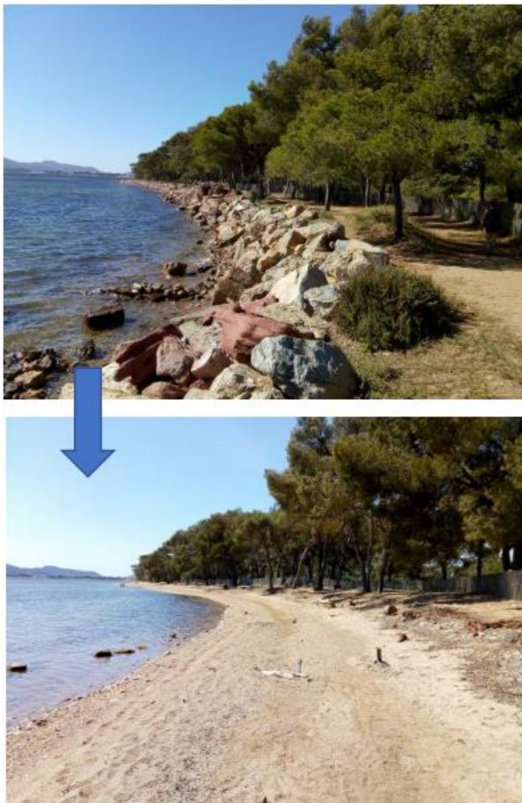
Figure 9 : Photo de terrain avant et après enlèvement des rochers de protection du trait de côte
