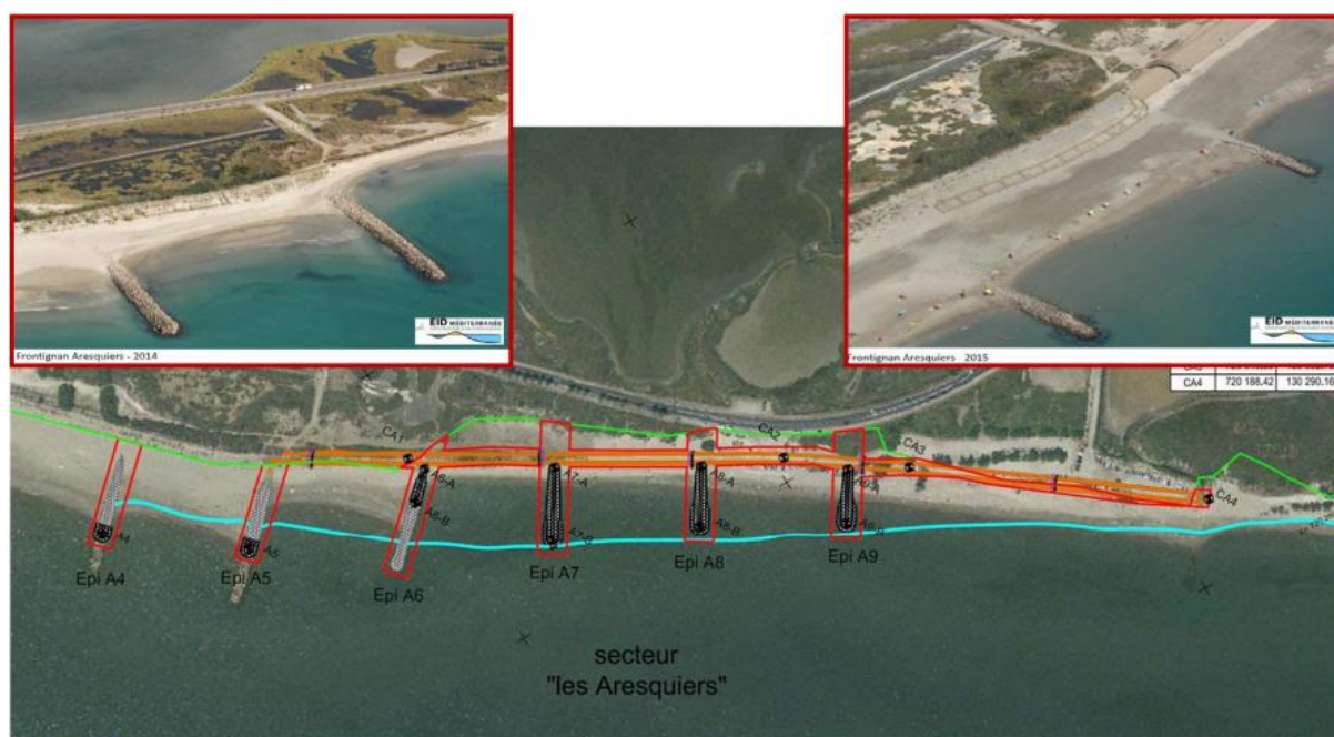
Figure 23 : travaux effectués sur le secteur des Aresquiers en 2015 (épis dégressifs, cordon dunaire, rechargement...)
