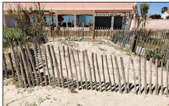
Ancien accès trans-dunaire condamné
