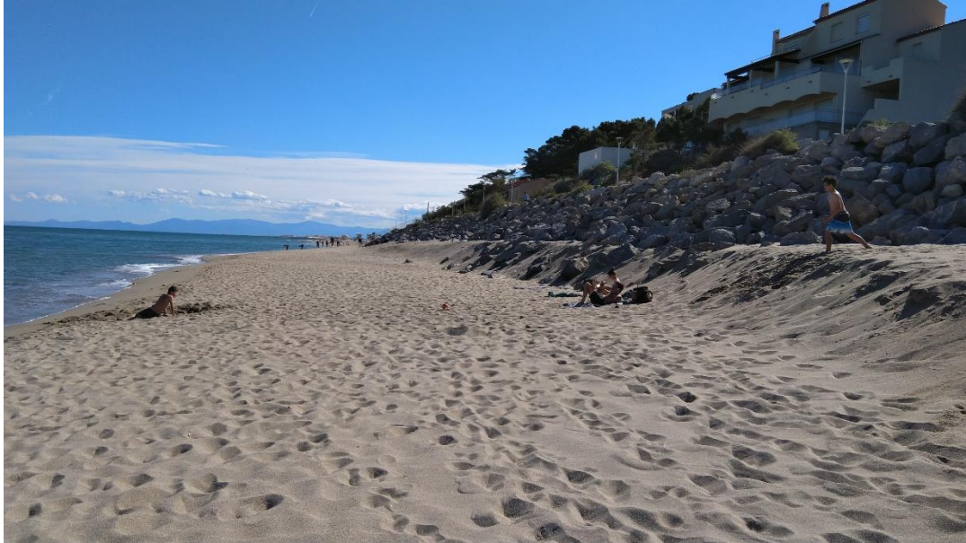
Illustration 229 – Impact érosif dans le tiers nord du secteur le long de la digue de haut de plage : abaissement de la topographie de la plage avec mise en nu du pied de l'ouvrage de défense.
