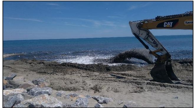
L'augmentation de la surface de la plage émergée bien visibles sur les photos ci-dessous juste après l'opération de rechargement n'a pas duré dans le temps.
