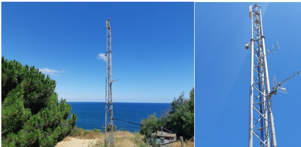
Illustration 63 : Caméra vidéo pour le suivi haute fréquence du site de la plage du Racou.
