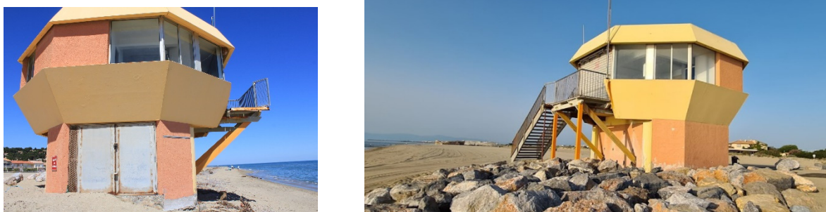
Illustration 231 : Poste de secours central de Leucate plage en 2018 (à gauche) et 2021 (à droite)
