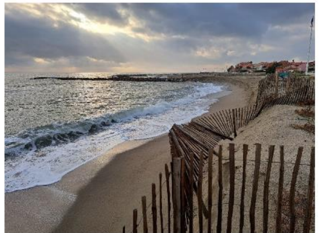
Erosion à Sainte-Marie (PMM) – Nov. 2022
